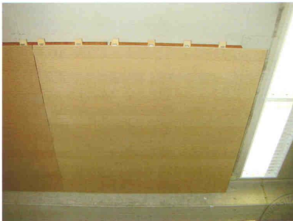
Bild 1 Gesamtansicht: Deckensichtseite „WoodWork AKUSTIPAN 13/3“
